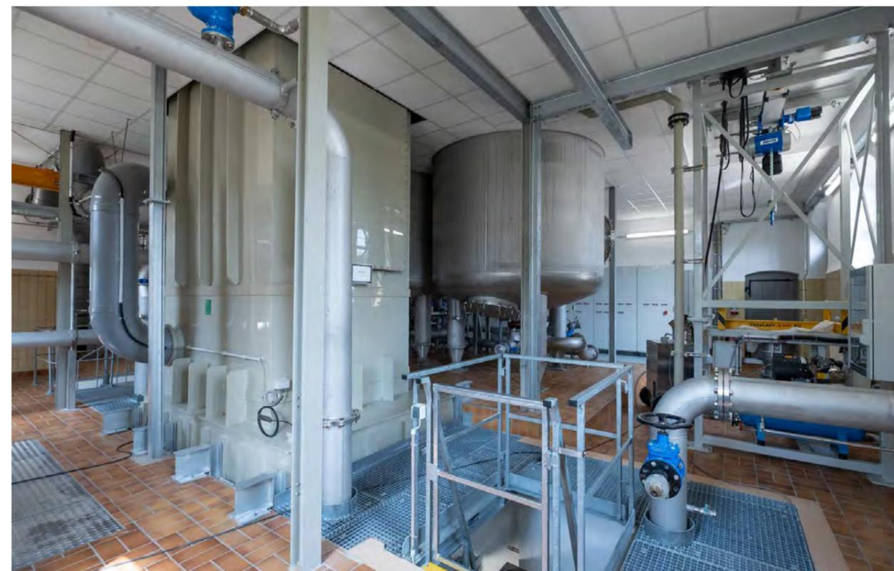
Im Wasserwerk Rauental werden PFAS aus dem Grundwasser gefiltert
